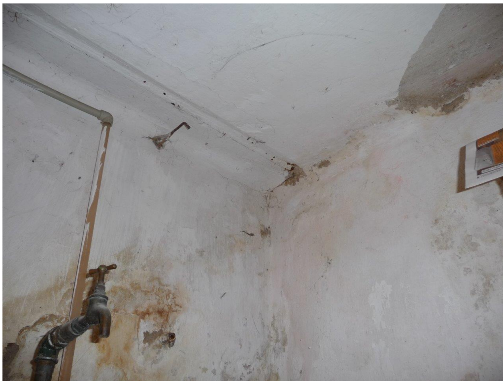
Foto č. 111 – Kotelna – vlhké stěny, trhliny ve stropě
