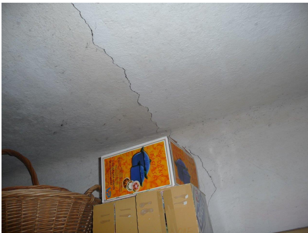
Foto č. 108 – Dílňa – trhlina ve stropě a na stěně - pokračování
