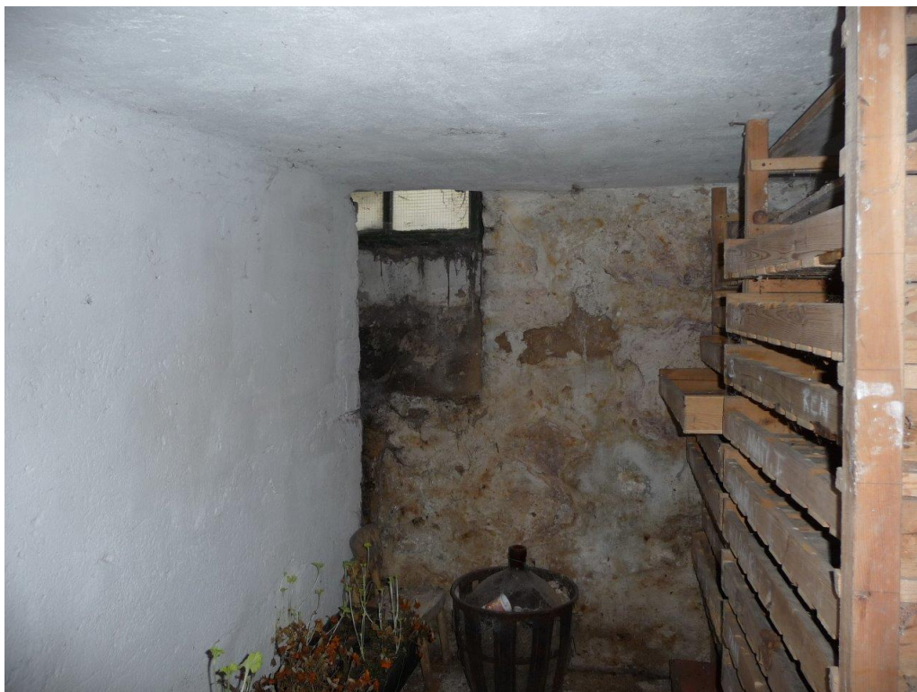
Foto č. 114 – Sklep – vlhké stěny, plíseň
