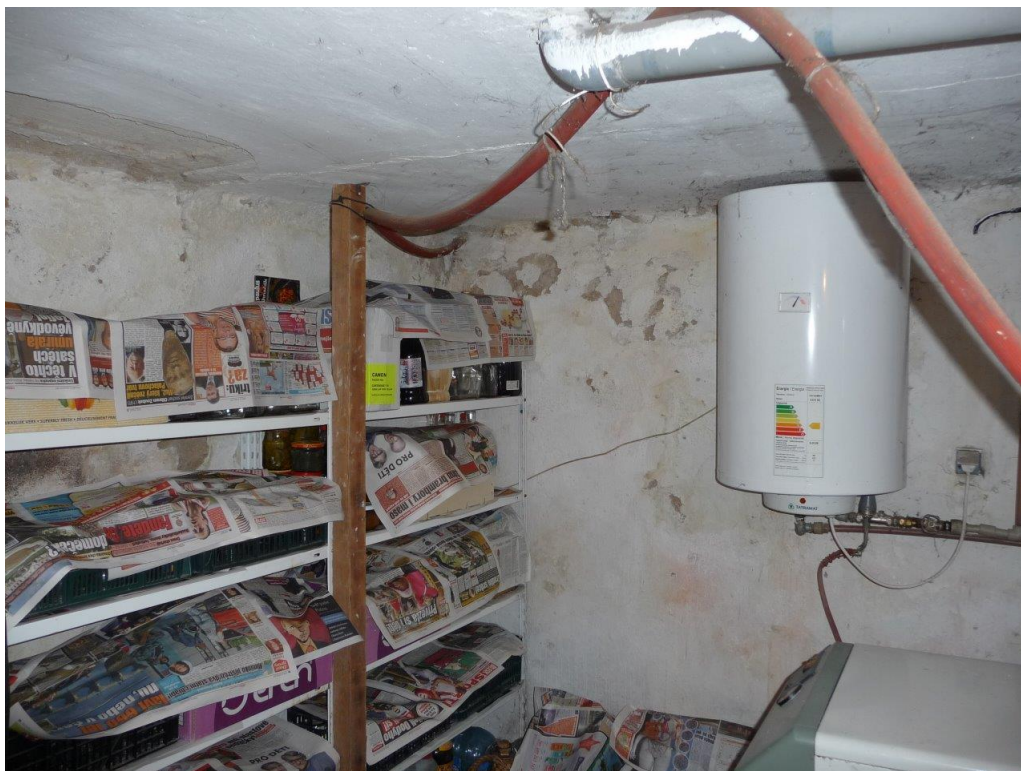
Foto č. 112 – Kotelna – vlhké stěny, opadaná omítka, trhliny ve stropě
