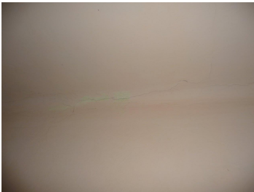
Foto č. 92 – Obývací pokoj – trhlina na rozhraní stěna - strop
