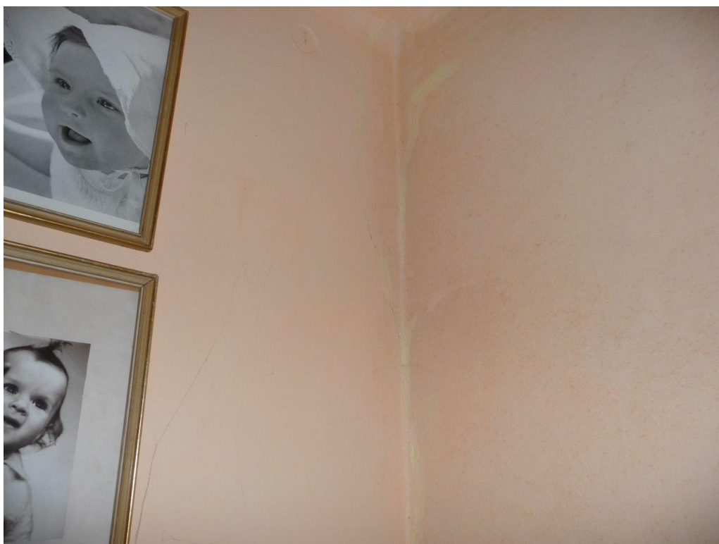
Foto č. 95 – Pokoj – trhliny na stěnách
