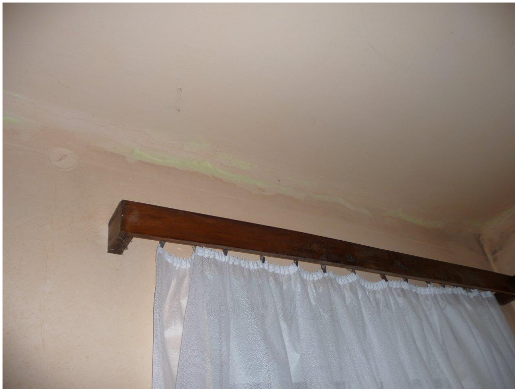
Foto č. 97 - Obývací pokoj – trhliny na rozhraní strop - stěna
