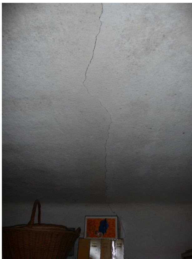
Foto č. 105 – Dílna – trhlina na stropě a na stěně
