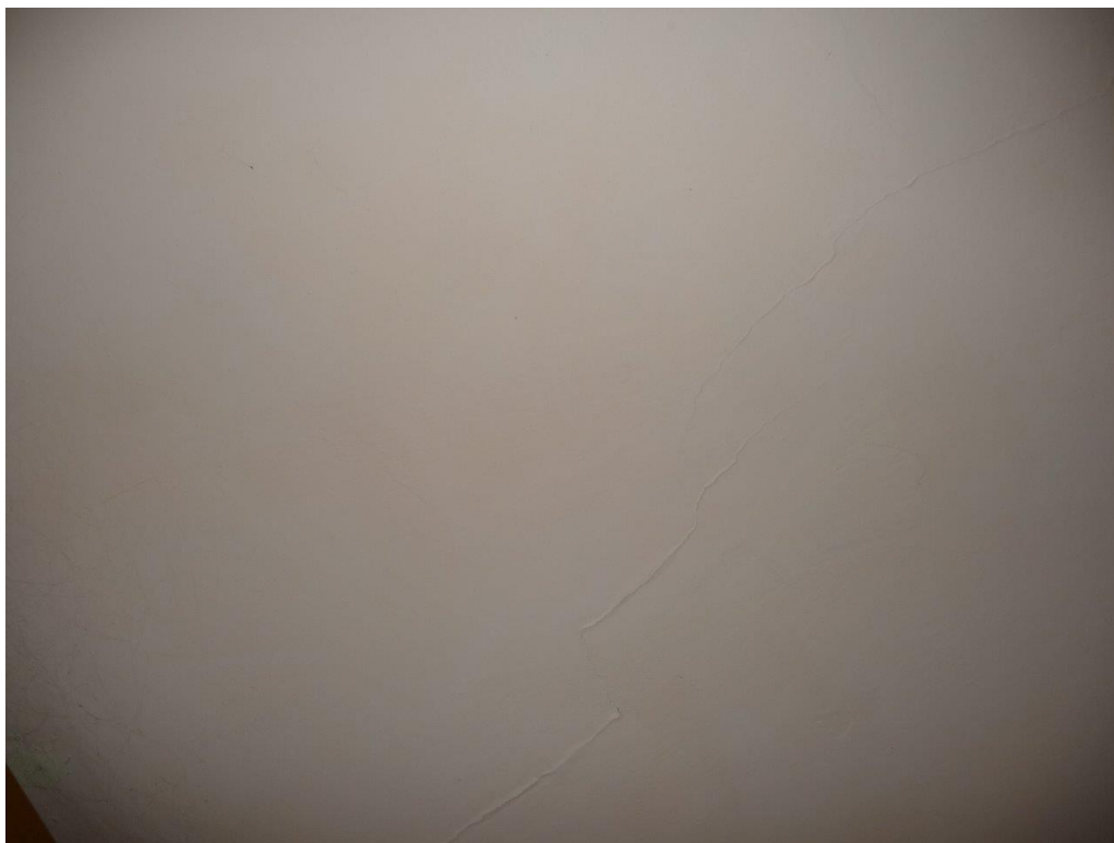
Foto č. 93 – Obývací pokoj – trhlina na stropě
