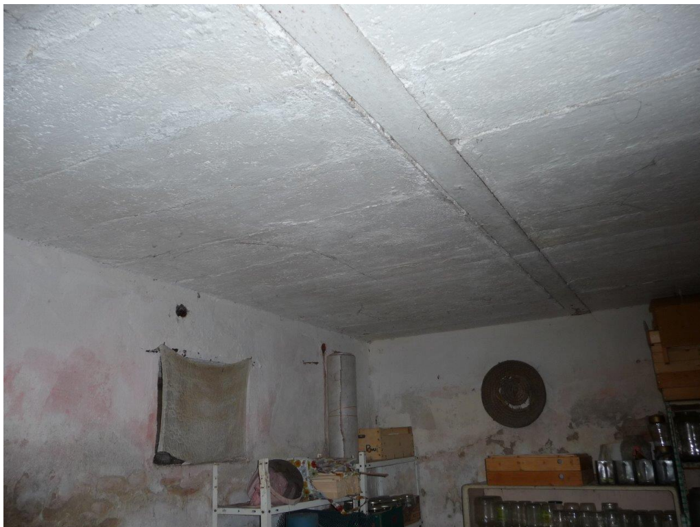
Foto č. 115 – Komora – vlhké stěny, opadaná omítka
