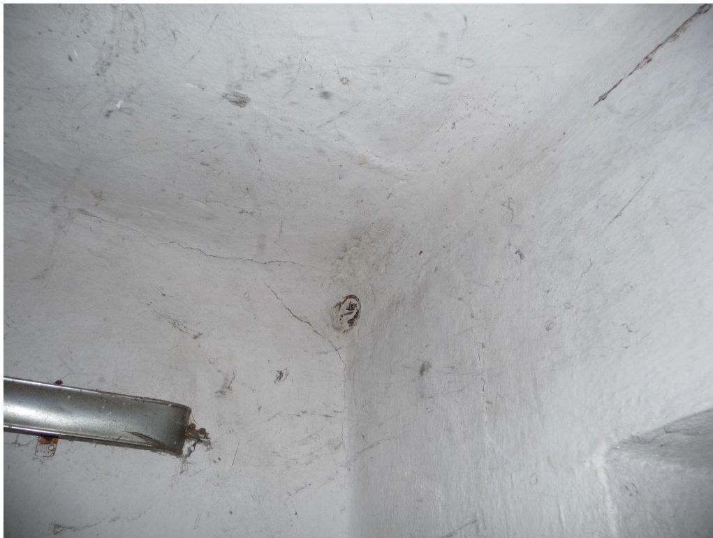
Foto č. 104 – Dílna – trhliny na stěně a na stropě
