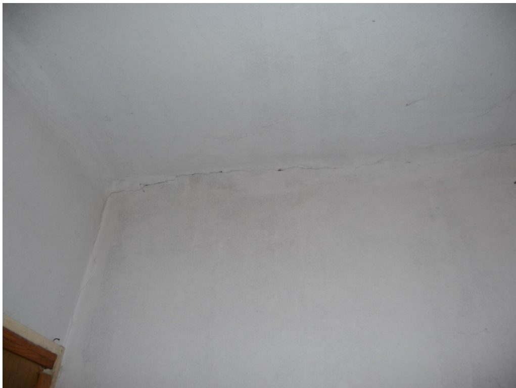
Foto č. 98 - Koupelna – trhliny na rozhraní strop - stěna
