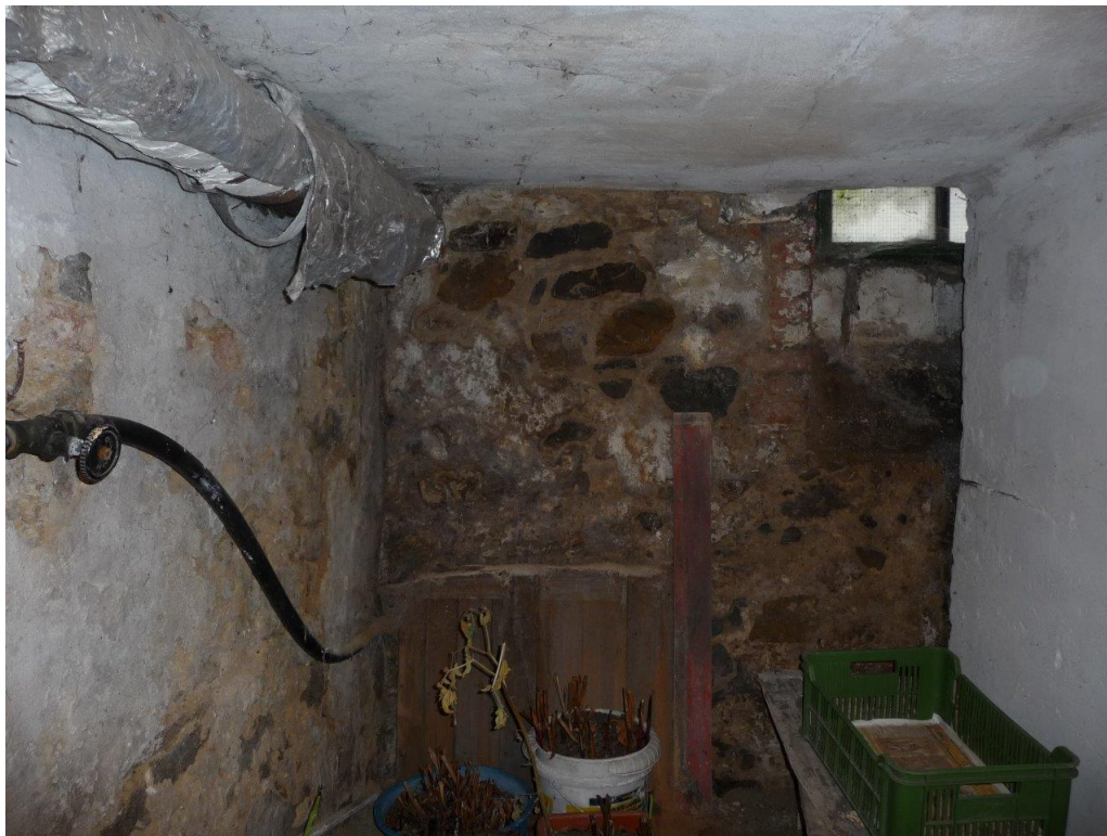
Foto č. 113 – Sklep – vlhké stěny, plíseň
