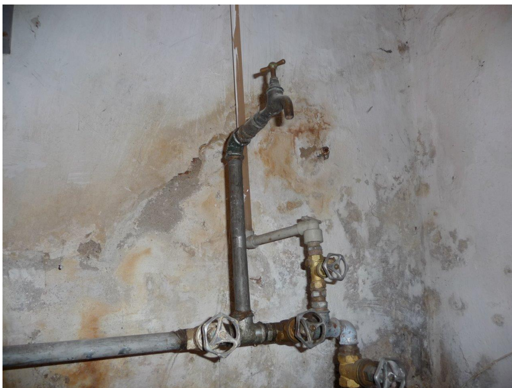
Foto č. 110 – Kotelna – vlhké stěny
