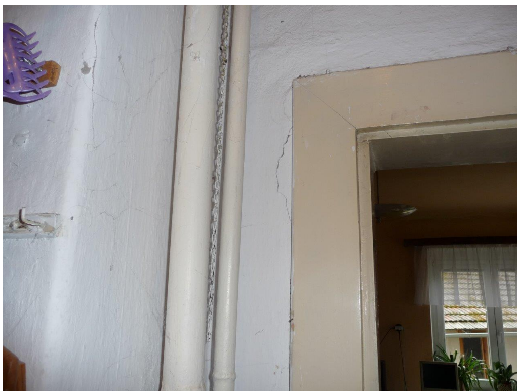
Foto č. 100 - Koupelna – trhliny u zárubně a na stěně
