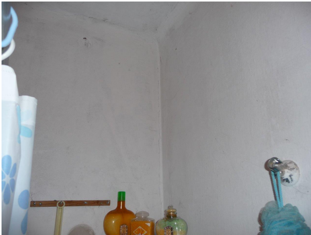
Foto č. 99 - Koupelna – trhliny v rohu
