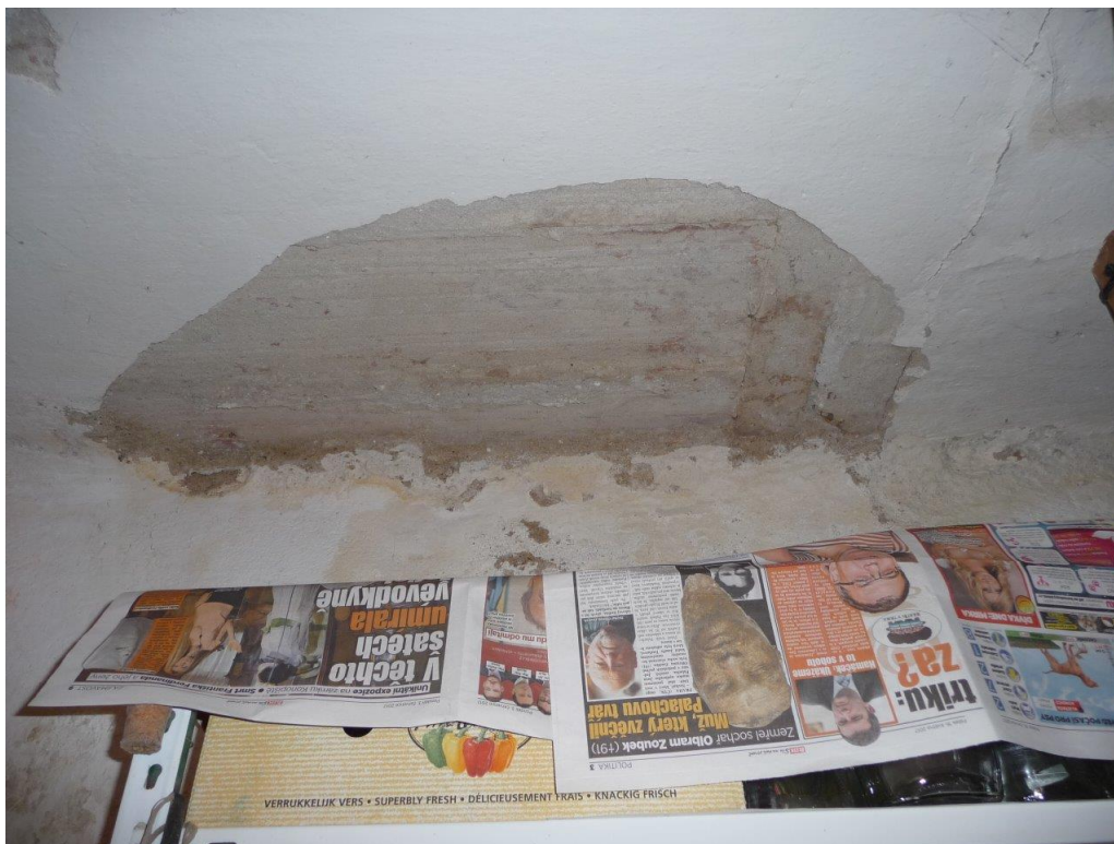
Foto č. 109 – Kotelna – vlhký strop a trhlina
